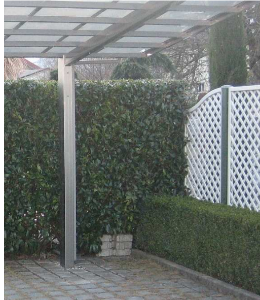
Bild 14: Montage des Regenrinnen – Ablaufes
