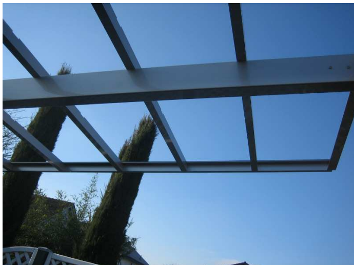
Bild 9+10: Montage der Seitenprofile
