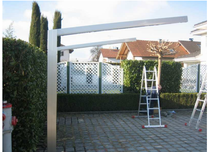
Bild 6: Montage der Dachträger
