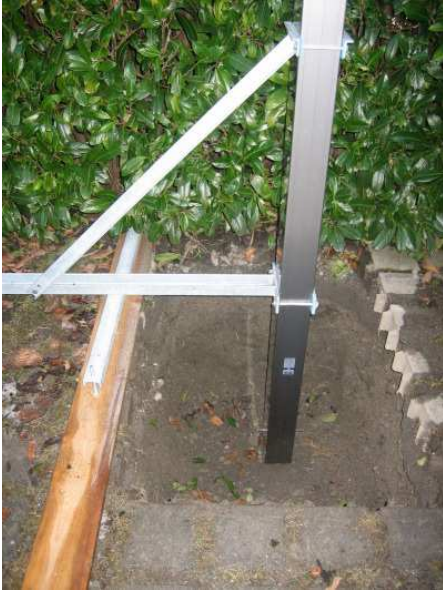
Bild 3 + 4: Beton einbringen und ca. 2 Tage aushärten lassen
