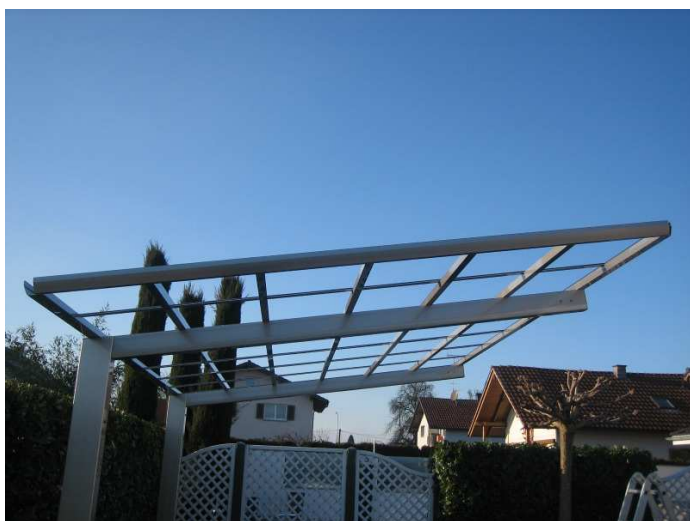
Bild 11: Montage der Querleisten
